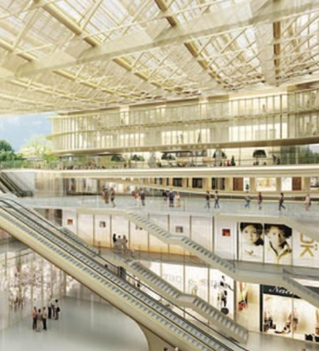
Le projet est limpide dans sa façon de faire circuler les efforts à l'intérieur de la structure, c'est-à-dire de répartir la pression exercée par le vent, la pluie, la chaleur ou le froid. Le vent par exemple sollicite les nervures, qui sollicitent la poutre en forme de lyre, qui sollicitent les bâtiments. Mais tout cela se calcule pour s'assurer de la stabilité de l'ouvrage.
