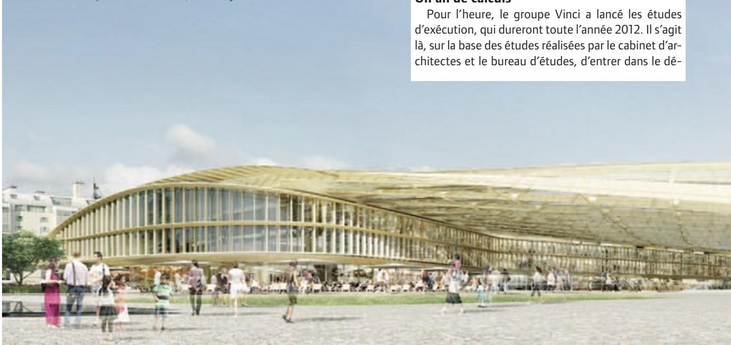
tail de chaque élément de l'édifice et de calculer le dimensionnement de l'ensemble des pièces en vue de leur fabrication et de leur assemblage. « Il faut par exemple, à partir du profil d'une poutre métallique donné, en déduire la section et les épaisseurs des éléments constitutifs, et définir les boulons qui serviront à son assemblage »
